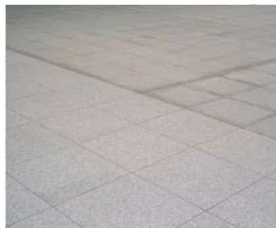
【イシノールシリーズ施工例】 右上:無処理施工 左下:イシノールシリーズ処理
