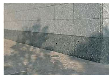
立ち上げ箇所及び床面のバサノロに使用
