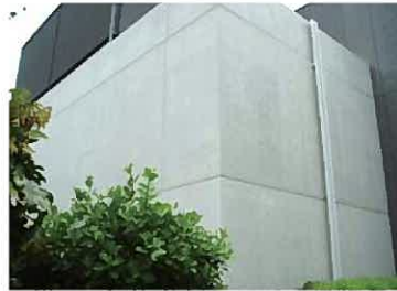
コンクリート打ち放し面 都内某所
