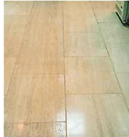
内装床(ホテルロビー) トラバーチン 研磨後塗布施工
