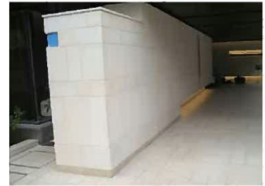
コンクリート2次製品に仕様 都内マンション
