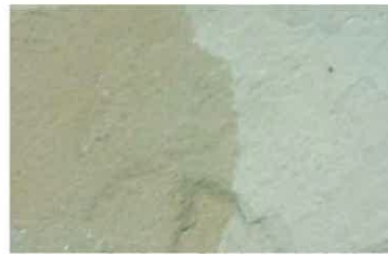
インド砂岩割れ肌仕上げ 左側：処理面 右側：無処理面
