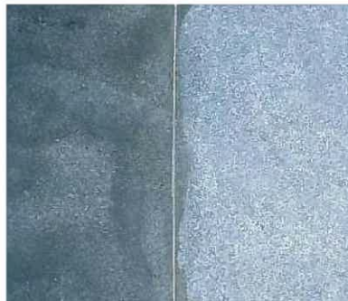
施工前 施工後
