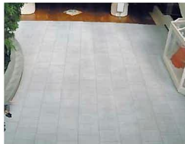
内装床(中野サンプラザ) 御影石 水磨き面 ワックスを剥離後、塗布施工
