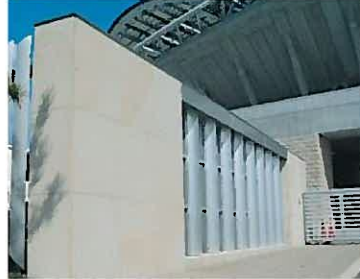
屋外塀(新潟スタジアム) 御影石小叩き仕上げ 新築時に塗布施工
