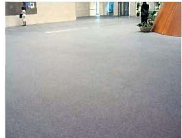
内装床(堂島アバンザ) 御影石バーナー仕上げ面 インクリーンシリーズで洗浄後、塗布施工
