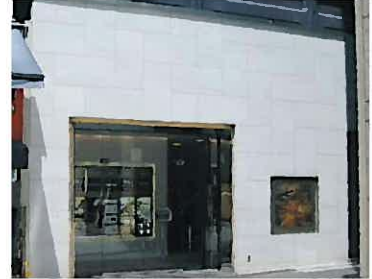
外壁 大理石鏡面仕上げ 改修、張り替え時に塗布施工
