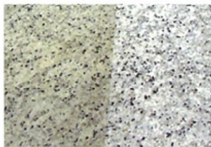
洗浄前 洗浄後 御影石水磨き 経年に渡る黄ばんだワックスの剥離
