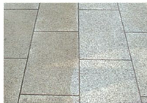
洗浄前 洗浄後 御影石水磨き仕上げ 外床の洗浄
