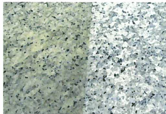
洗浄前 洗浄後 御影石水磨き 経年に渡る黄ばんだワックスの剥離
